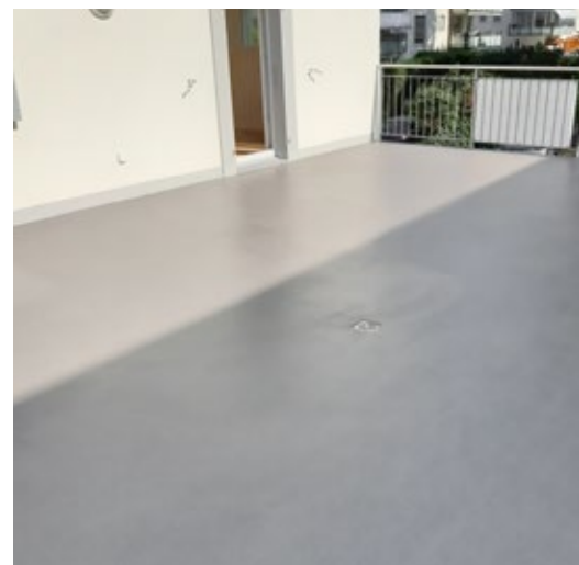
La surface est finie et prête à l'utilisation
