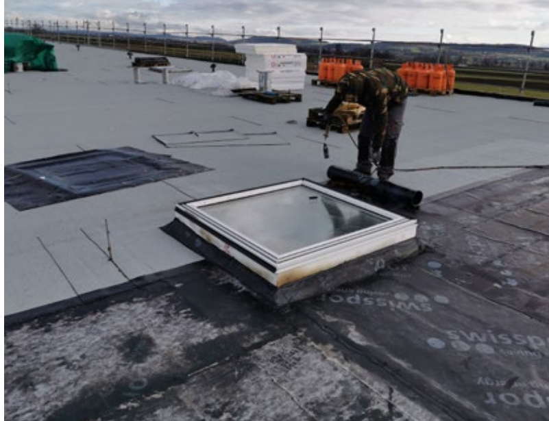
Raccords et détails sur un lanterneau (2 ème couche)
