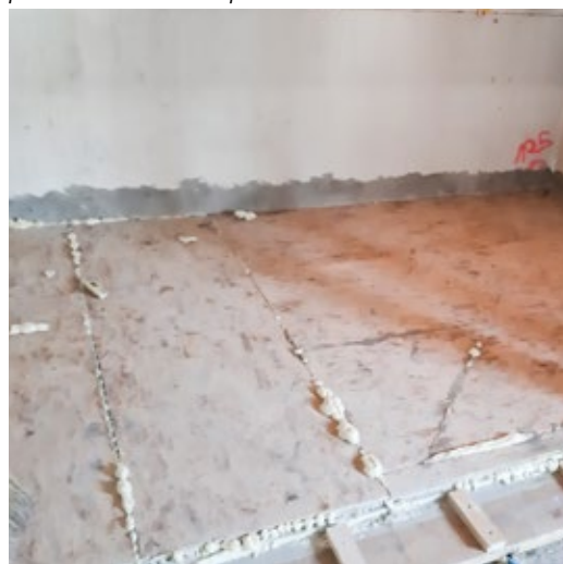
Pose du support en OSB pour l'étanchéité liquide
