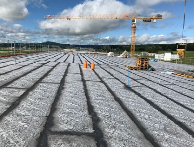
La toiture mise hors d'eau
