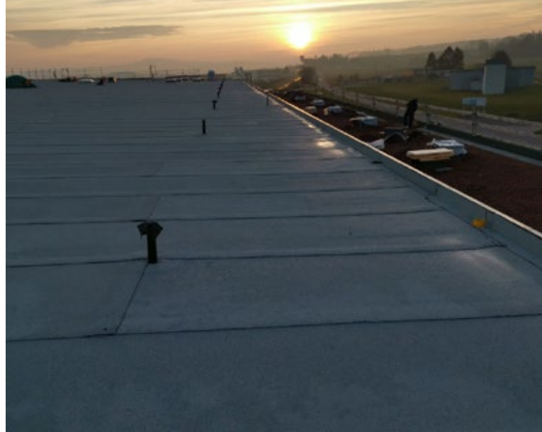
Le système d'étanchéité est terminé
