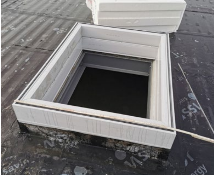
Raccords et détails sur un lanterneau (1 ère couche)
